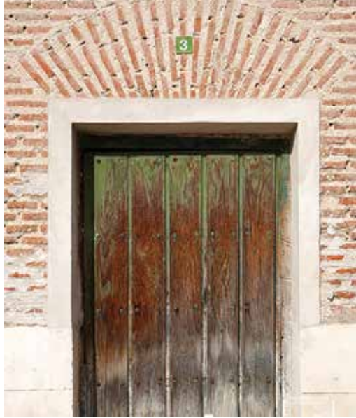
► Puerta de vivienda en Alcazarén
